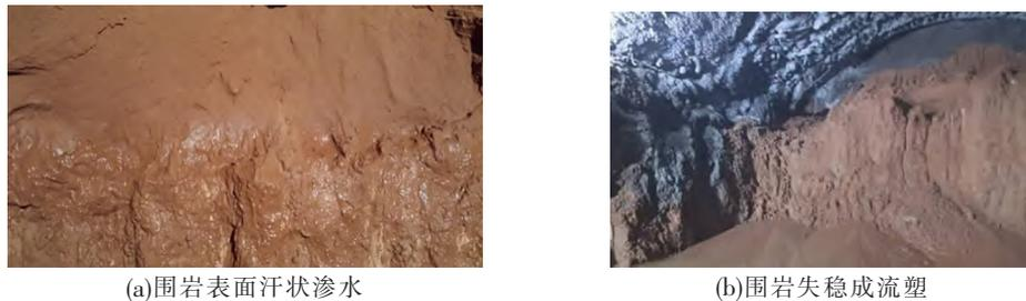
图 1 掌子面砂岩遇水软化
