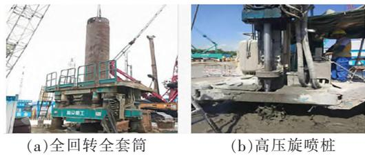
图 5 全回转咬合桩+双排高压旋喷桩双重护槽现场施工
