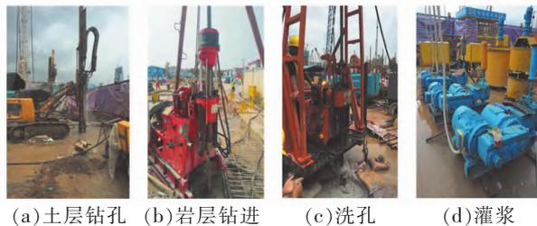
图 8 基岩破碎带双液灌浆加固技术施工流程
