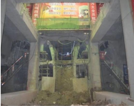
图 10 扣拱混凝土施工前
