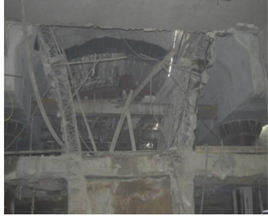
图 11 分段凿除临时支撑
