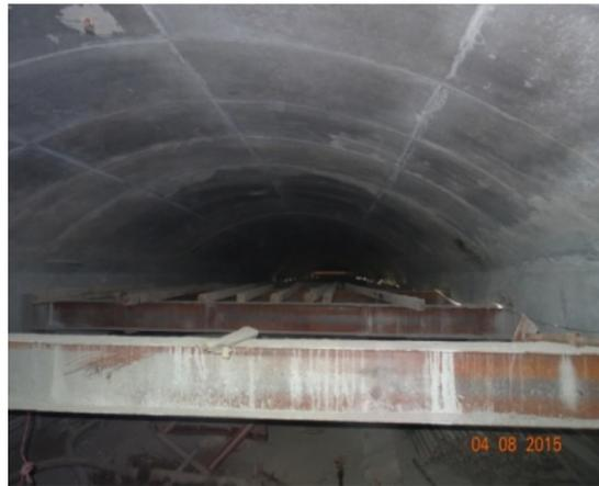
图 13 扣拱混凝土完成
