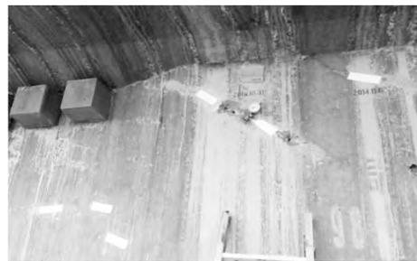
图 1 梁端斜裂缝开展情况图
