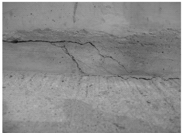
图4 沥青砂浆斜裂缝
