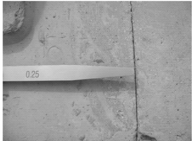
图2 轨道板宽接缝后浇混凝土的裂缝
